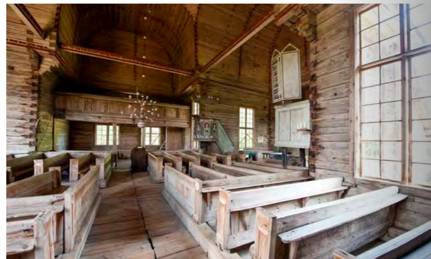
Innenraum Eine auf den Innenraum abgestimmte Belichtung führt zu einer Überbelichtung der Fenster, der Aussenräume.
